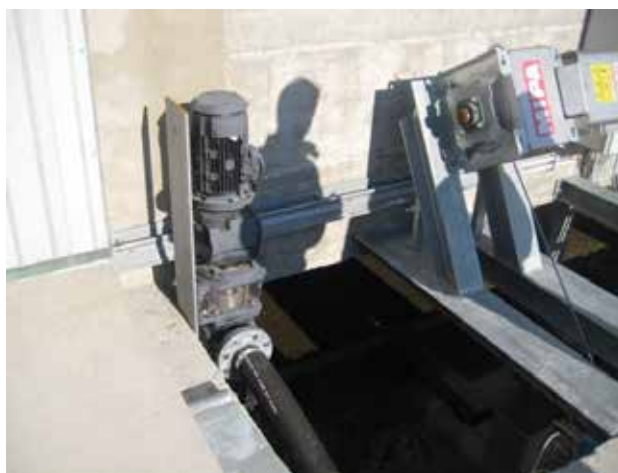
Čerpadlo DV Stroj je ponořen přímo do produktu, a tedy není nutné sací potrubí, což snižuje zástavbové rozměry na minimum.
