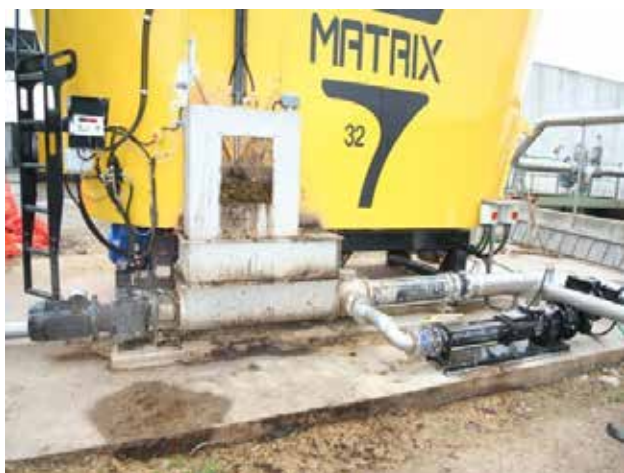
Čerpadlo DHS-T a DN Přenos biomasy do vyhřívací komory se vstřikováním kapalné fáze.
